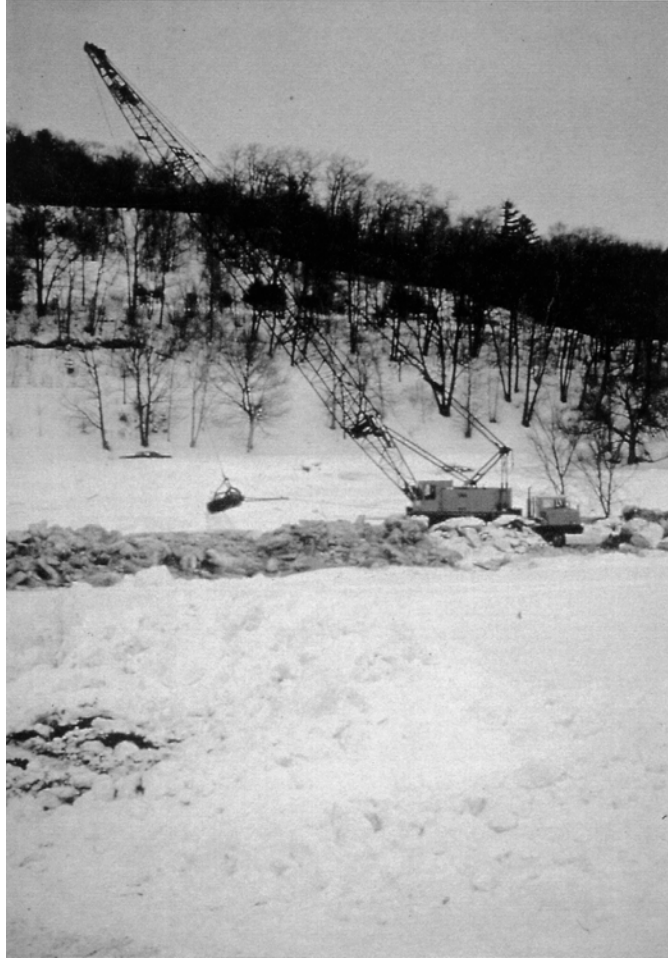
a. Using a dragline
