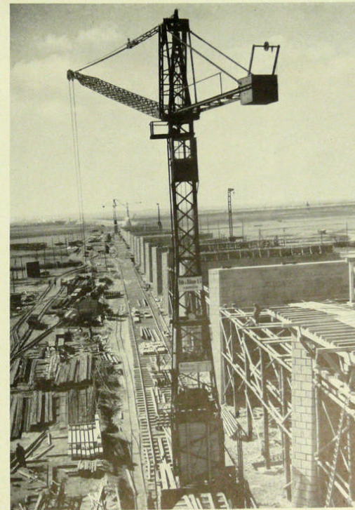
Blick über die Pfeiler der Flutbrücke. Baustelle im Frühjahr 1936
