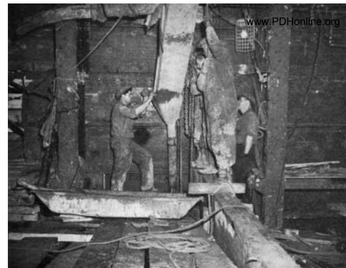
Tremie method concrete pour
