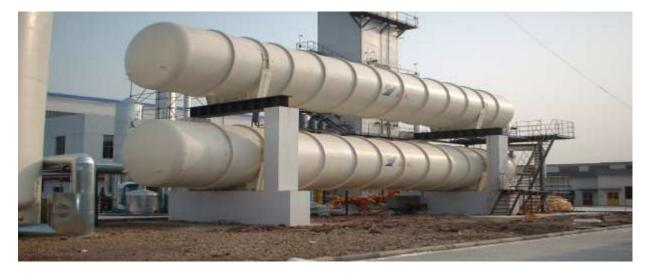
FIGURE 15: HORIZONTAL CRYO STORAGE TANK SYSTEMS
