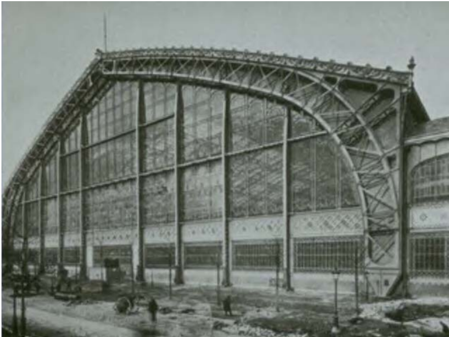
Galerie des Machines
